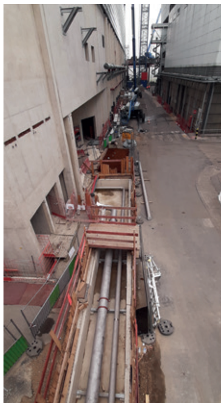
➤ Caniveau vapeur connecté au réseau CPCU. ➤ Groupe turbo-alternateur.
