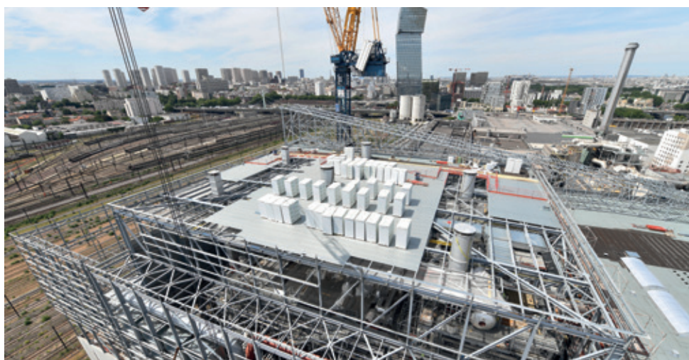
❷ Vue aérienne de la toiture du bloc fours/Chaudières / traitements des fumées.
