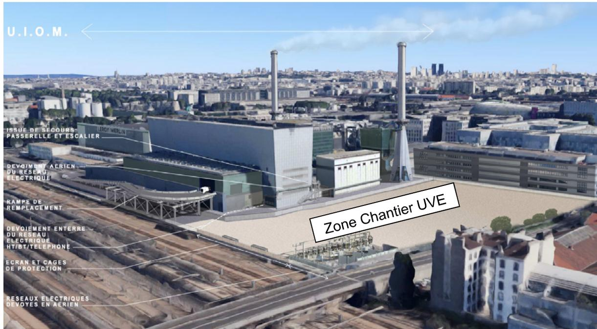
Par ailleurs, des études géotechniques ont été menées pour déterminer les caractéristiques des sous-sols au droit des ouvrages. La conception même du projet est réalisée de façon à ce que les fondations soient bien adaptées aux installations. Les modifications sur la géologie resteront localisées à l'emprise de l'UVE et ne seront pas de nature à générer des mouvements de terrains susceptibles de perturber l'exploitation de l'UIOM.
